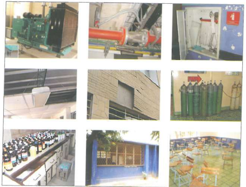
شکل ۴- (۱) محفظه شلنگ‌های آتش‌نشانی H&S (۲) اتصالات انعطاف‌پذیر در لوله‌ها H (۳) مولدهای اضطراری با مدل مهاربندی‌های بزرگ (H)؛ (۴) سیلندرهای گاز (H)؛ (۵) پوشش نمای ساختمان (H&S)؛ (۶) سقف کاذب (H&S)؛ (۷) میزها و تخت‌نسیاه (S)؛ (۸) پنجره کلاسی‌های درس طبقه همکف (S)؛ (۹) مایعات خطرناک شیمیایی (H).
