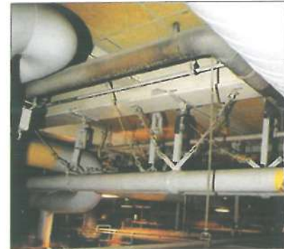
شکل ۷- مهابد بندی و استفاده از تابلو
