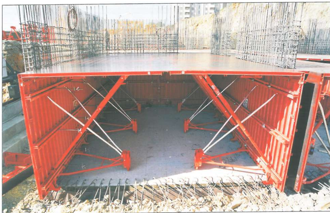
قالب‌های به‌صورت لانه‌مگس هستند و جانمایی برقی و تأسیسات هیدرمان را آسان‌تر می‌کند. در دیوارها صورت می‌گیرد.
