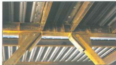
شکل ۳ - انواع مختلف مهاربندی جانبی تیر رابط
