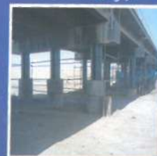
پل کالشمور محور تریب حیدریه گناباد (EPC)
