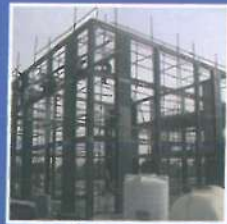
مسجد فرودگاه بین المللی قشم (EPC)
